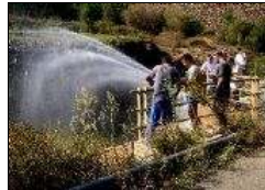
Obreros de la empresa cacereña Boymosa trabajando ayer en la presa Rivera de Gata. Foto:A. M. C.
